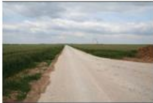
Figure 18 : Exemple de chemin d'accès pour les éoliennes
